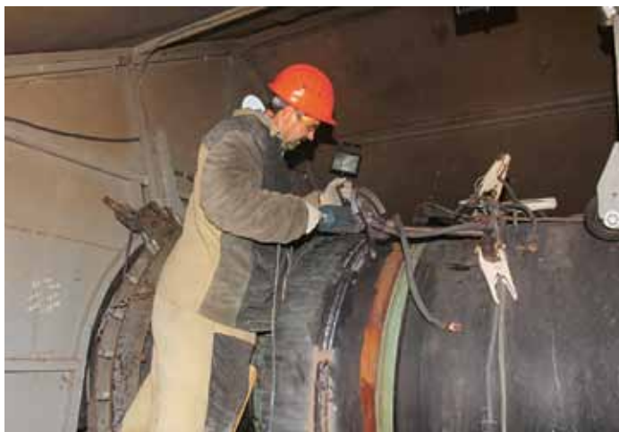
De havsbaserade och landbaserade segmenten svetsas ihop i Ryssland.
