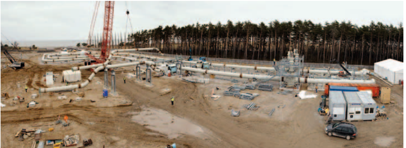
Arbetena offshore med utläggningen av gasledningarna vid den tyska landanslutningen avslutades i december. Arbetet fortskrider också på land.
