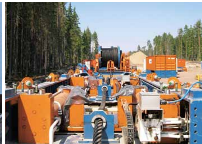
Rörledningarna drogs i land med en kraftig dragvinsch monterad på land. Vinschen väger 100 ton.
