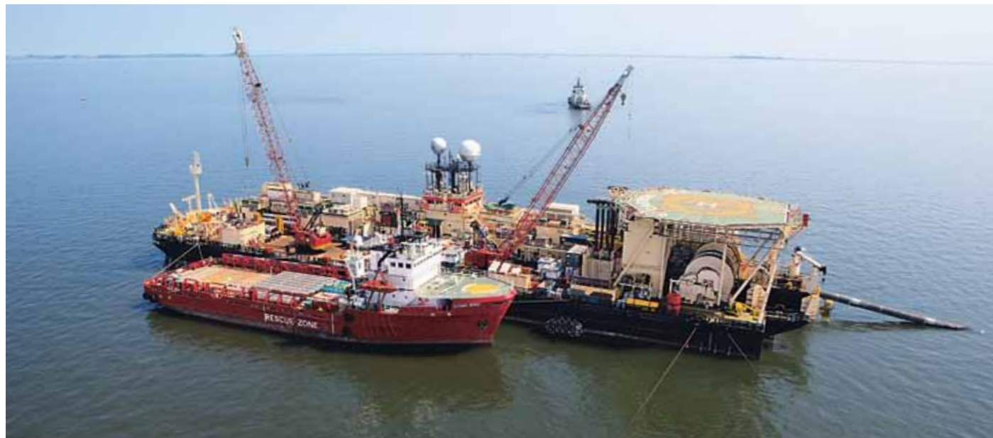
Castoro Dieci, ett flatbottnat, grundgående rörlägningsfartyg, började arbeta i de grunda vattnen i tyska Greifswalder Bodden i slutet av juni. Det lägger ut den kortaste delen (28 kilometer) av de båda parallella gasledningarna.
