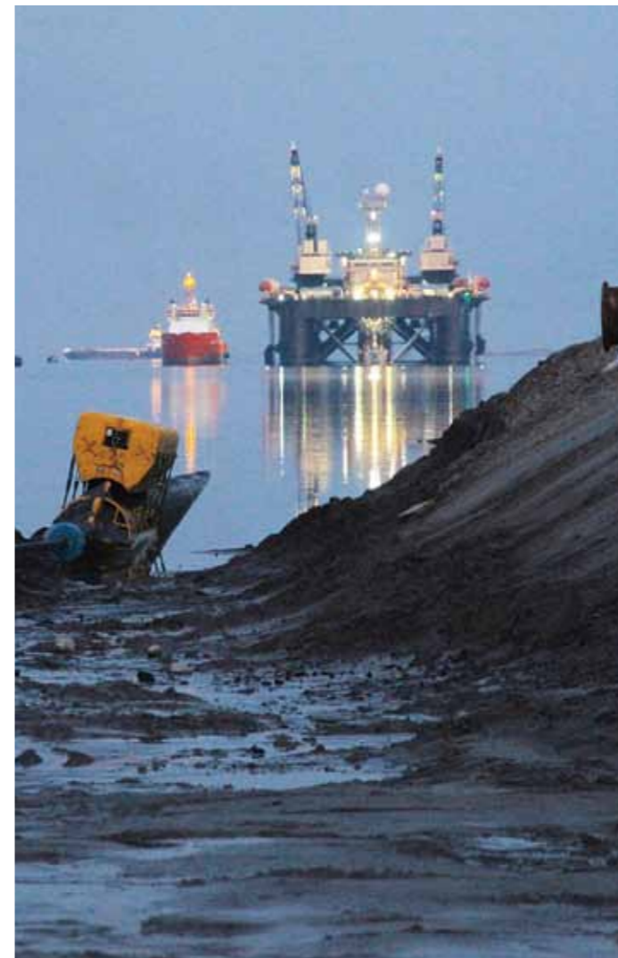
Den första ledningen drogs i land till den ryska landanslutningen den 28 juli, den andra den 4 augusti. Castoro Sei ligger cirka 1 300 meter från land.
