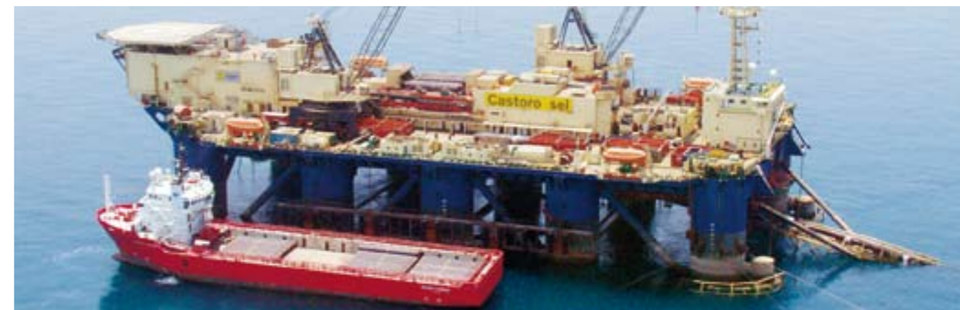
De första rören kommer att transporteras till rörlägningsfartyget Castoro Sei under våren 2010 när byggstarten beräknas ske.
