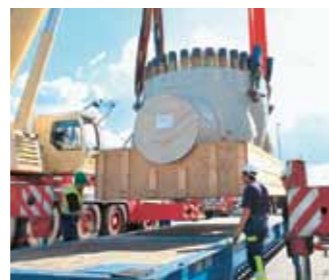
Погрузка задвижки весом 102 тонны на грузовую платформу.
