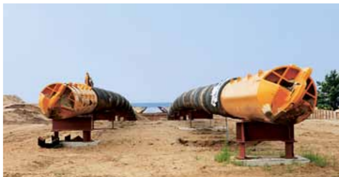
Протаскивание газопровода на берег завершено в немецком Любмине: первая нитка протаскана 3 июля, вторая нитка – 16 июля.
