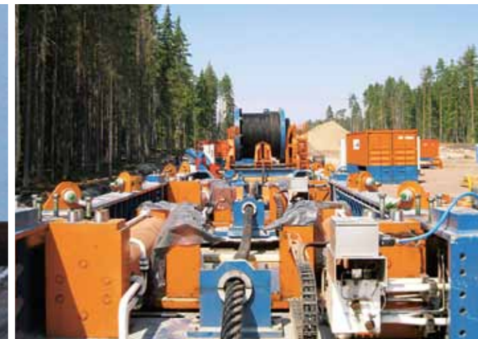
Протаскивание газопровода осуществлялось с помощью мощной лебедки, установленной на берегу.
